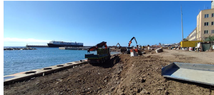
Visita a la zona de obras.
