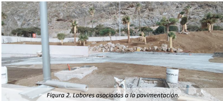
Figura 1. Pavimentación del lado sur.
