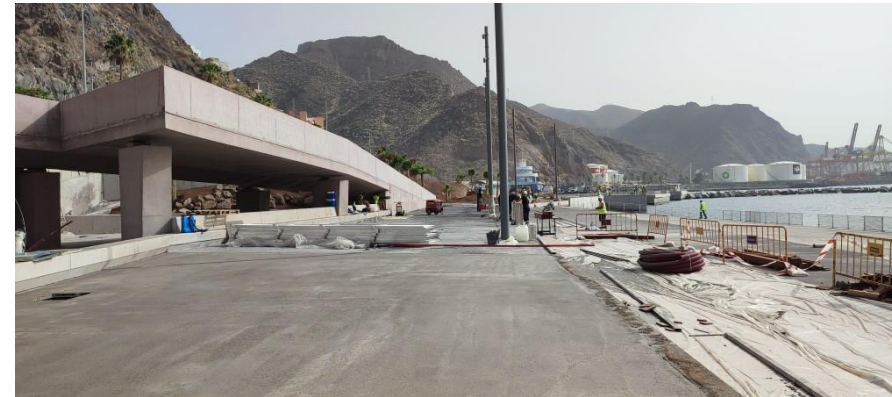
Visita a la zona de obras.
